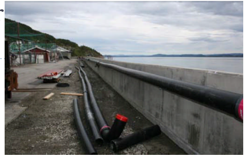
Figur 18: Sikring av anleggsområde
