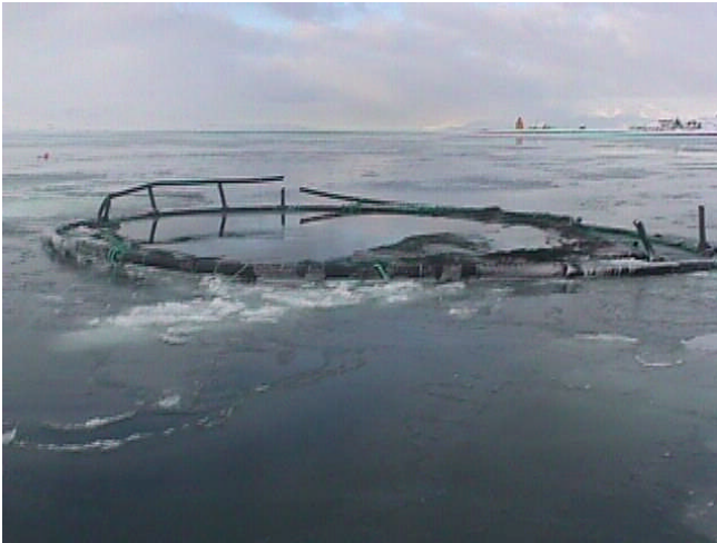
Mynd 4.7. Rekís hefur valdið tjóni á tómri sjókví í Eyjafirði (Ljósmynd: Óttar Már Ingvarsson).
