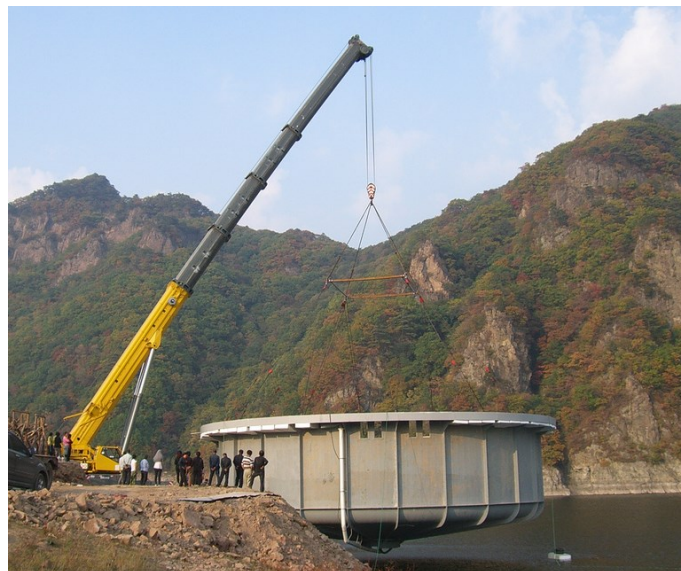
Mynd 1.17. Fljótandi lokuð eining sem verið er að sjósetja ( http://agrimarine.com ).
