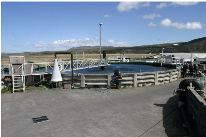
Mynd 3.6. Forsteyptar einingar hjá Silfurstjörnunni (Ljósmynd: Valdimar Ingi Gunnarsson).
