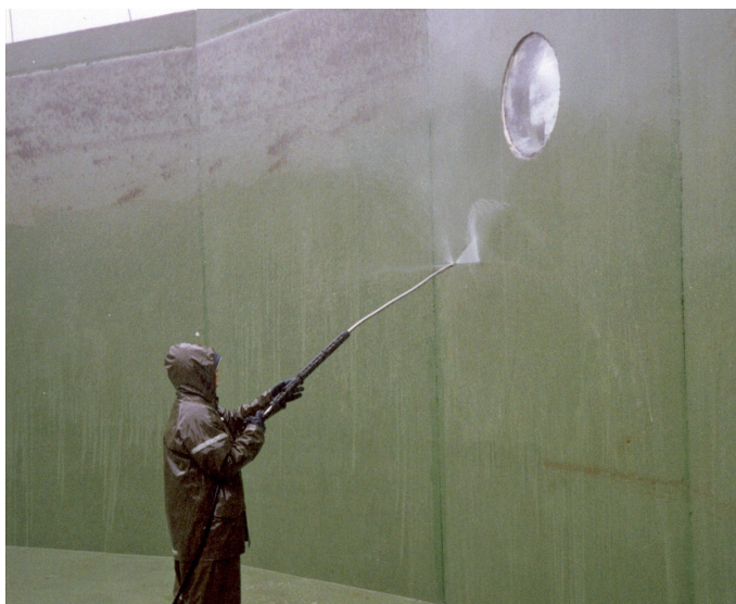
Mynd 3.8. Kar hjá Íslandsbleikju á Vatnsleysu málað með epoxy þrífið að innan (Ljósmynd: Valdimar Ingi Gunnarsson).
