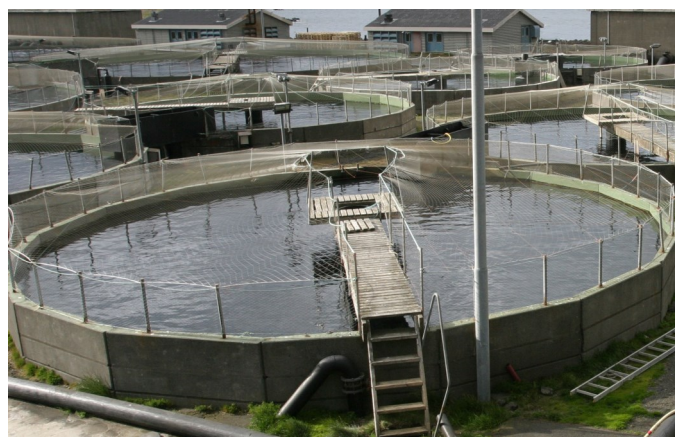
Mynd 3.5. Forsteyptar einingar hjá Íslandsbleikju, Vatnsleysu (Ljósmynd: Valdimar Ingi Gunnarsson).
