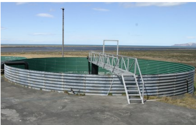
Mynd 3.12. Bárújárnskar hjá Silfurstjörnunni (Ljósmynd: Valdimar Ingi Gunnarsson).
