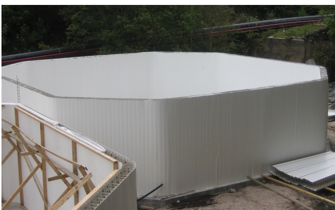
Mynd 3.9. Plastmót fyllt með steypu (www.octaform.com).
