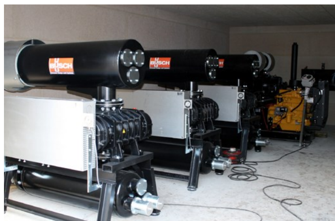
Mynd 4.42. Loftpressur í danskri landeðisstöð (Ljósmynd: Sören Jøker Trachsel).
