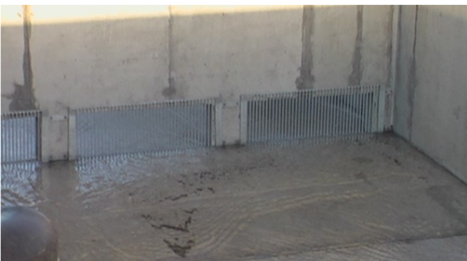
Mynd 4.28. Rist á milli eininga (eldisþróa) í lengdarstraumskari hjá Fiskeldinu Haukamýri (Ljósmynd: Fannar Helgi Þorvaldsson).
