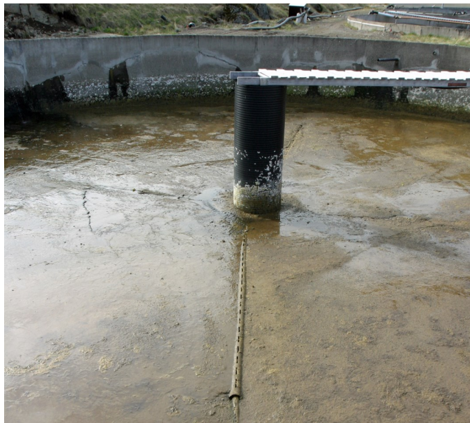
Mynd 4.18. Einföld útgáfa af stjörnufrárennsli hjá Bæjarvík í Tálknafirði (Ljósmynd: Valdimar Ingi Gunnarsson).
