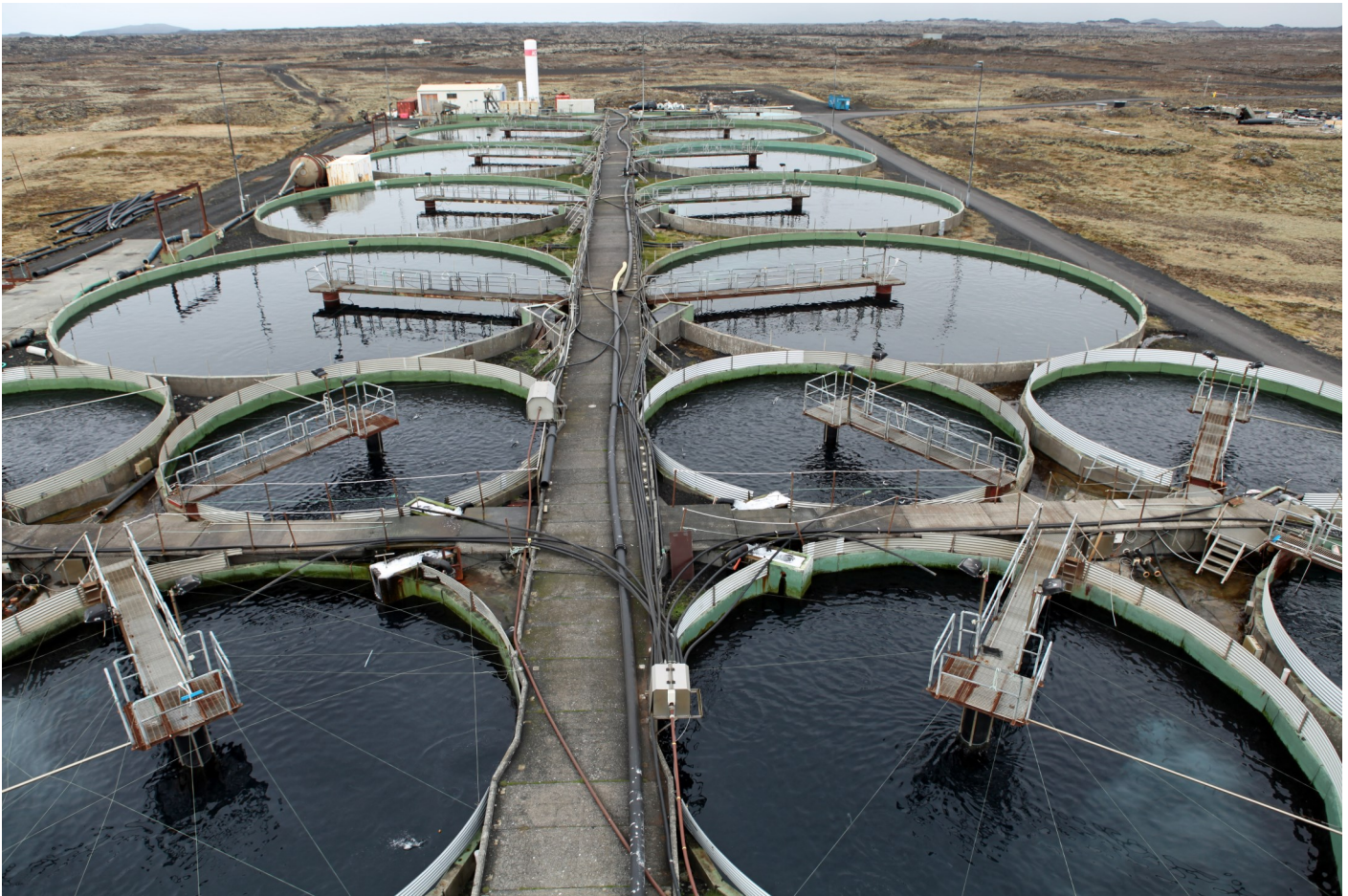
Mynd 4.2. Hjá Íslandsbleikja á Stað er vatnið leitt úr miðlunartanki um stökk í kör (Ljósmynd: Valdimar Ingi Gunnarsson).
